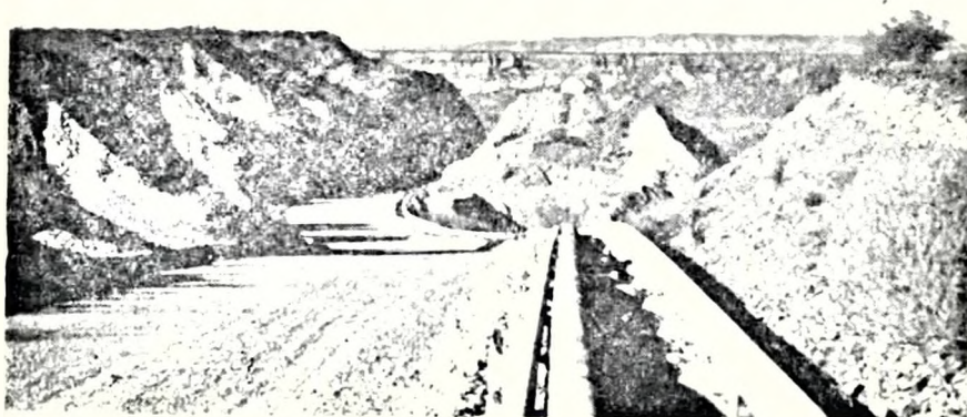
Fot. 5 — Vista tomada desde el norte hacia el sur, en el camino La Ventana a Punta de las Bardas. Área Las Hormigas — Río Vieja. Zona de glaciares típicos. En primer término restos de un glacis local afectado por el trazado del camino (Cañerías = acueducto + gasoducto + oleoducto). En segundo plano el mismo nivel de glacis local, continuo. En tercer plano —al fondo— se destaca el techo del glacis principal, en coincidencia con la zona de Vacas Muertas y Punta de Las Bardas. Notar la claridad de la "planización" dentro del glacis local o "glacis de sustitución".
