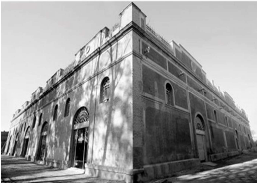
Figura 12: La fachada de Bodega Los Toneles
