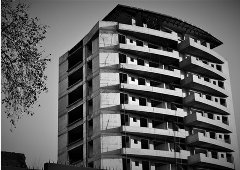
Figura 11: La Torre de 12 pisos.
