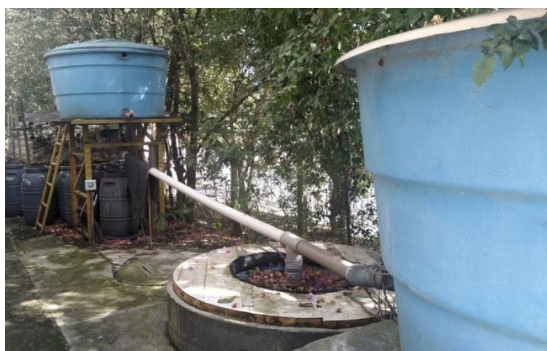
Figura 8. Biodigestor ao lado do prédio do NPDEAS.
