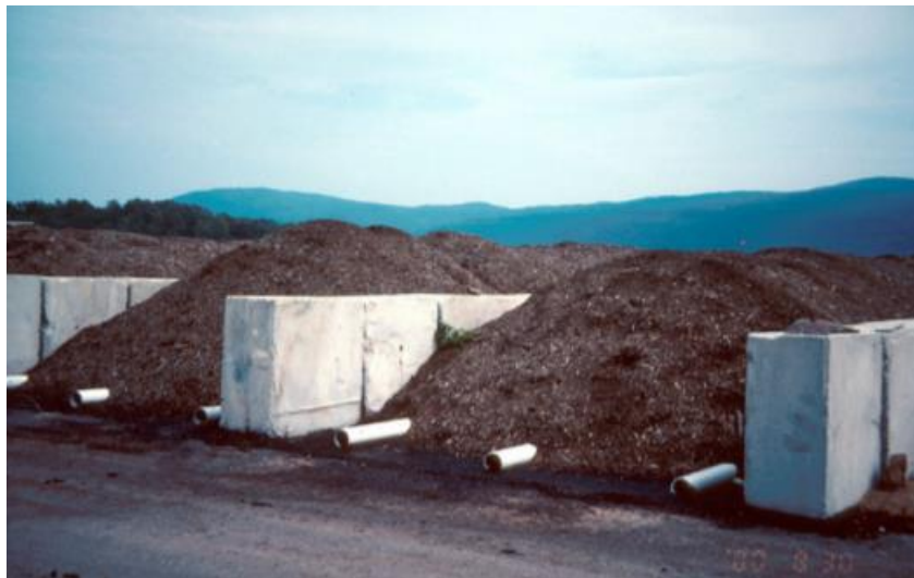
Figura 4: Instalación con varias hileras de ventilación pasiva, mostrando tubos horizontales perforados para facilitar el intercambio gaseoso.
