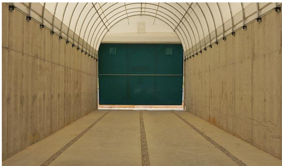
Figura 25: Interior de una cama de maduración. Pueden distinguirse 3 canaletas en el piso cubiertas de grava.
