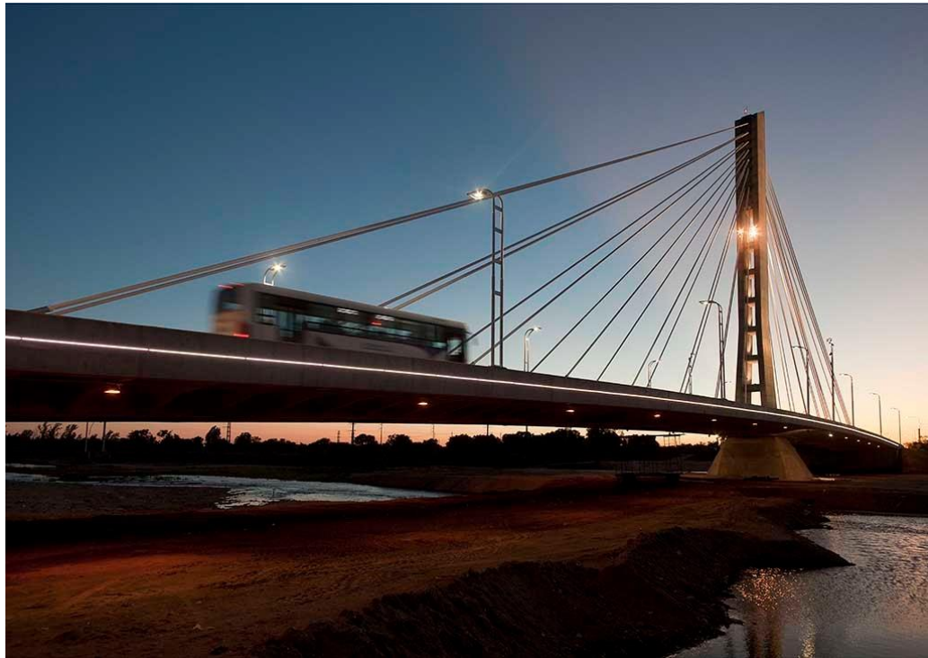
Figura 7: Puente Monseñor Francisco Miranda, San Luis, Argentina.
