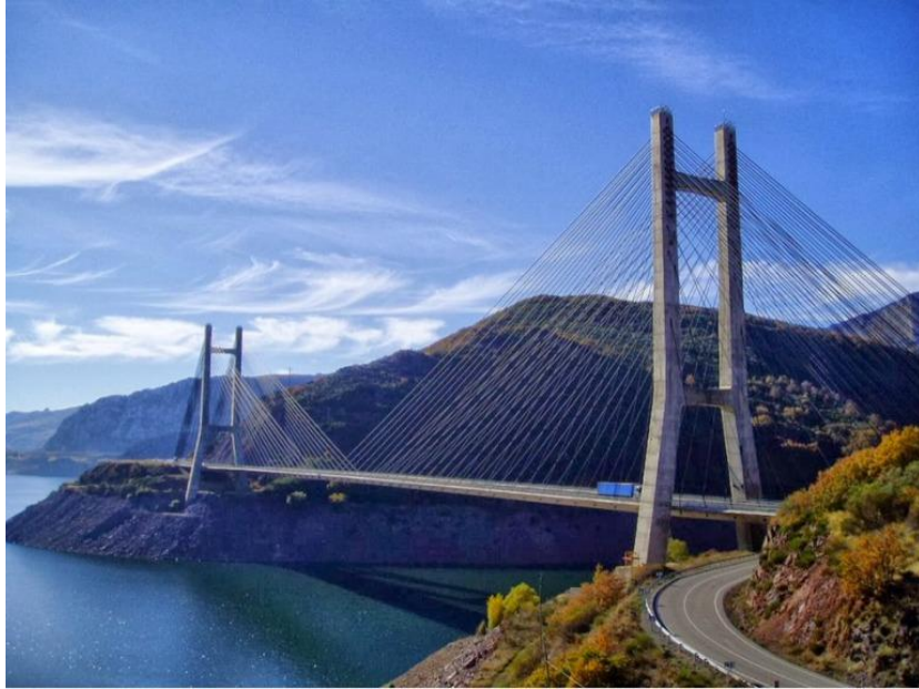
Figura 10: Puente Ing. Carlos Fernando Casado, España.
