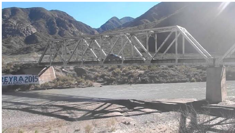
Figura 5: Vista lateral del puente Anderson Blog Ride.
