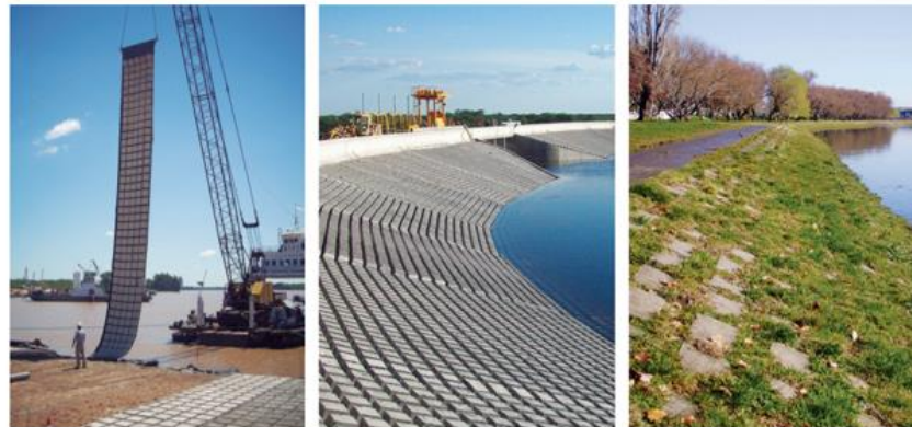
Figura 115: Revestimiento de bloques de hormigón unidos con geotextil.
