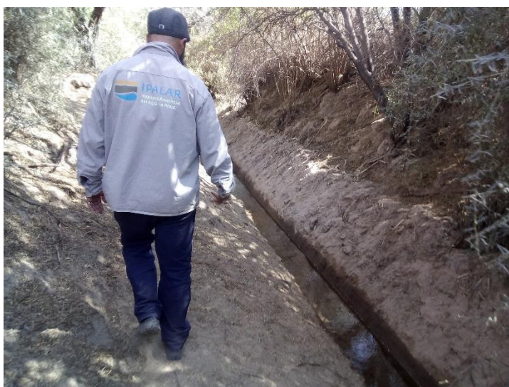
Fig. 21. Recorriendo con personal del Instituto Provincial del Agua de La Rioja (IPALAR) – delegación Vichigasta la zona de canales, galería filtrante y cámaras (Imagen Montilla, 2019)
