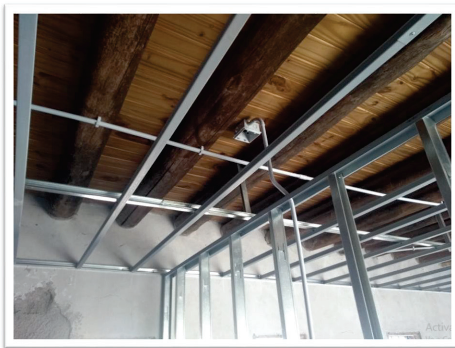
Ilustración 14 Armado de perfilería para tabiques y cielorrasos
