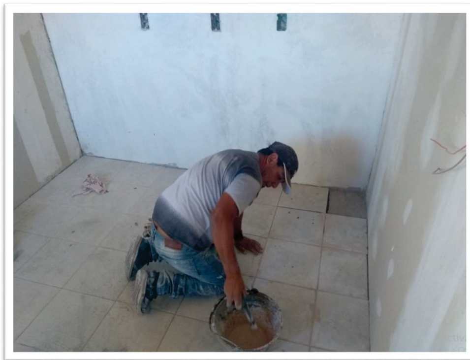
Ilustración 19 Colocación de cerámicas
