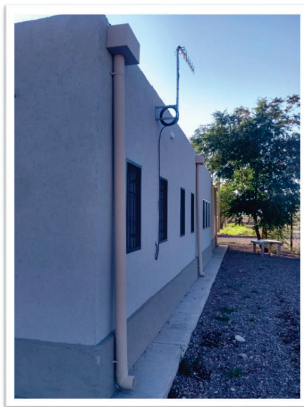
Ilustración 21 Sistema pluvial
