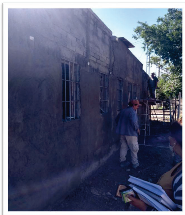
Ilustración 16 Revoque grueso exterior
