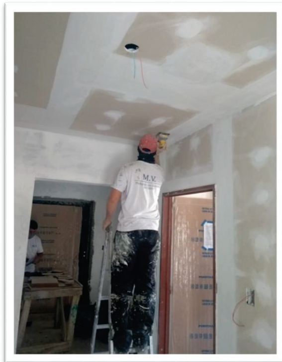
Ilustración 17 Lijado sobre Durlock
