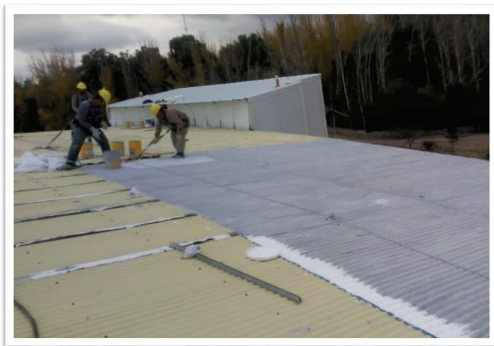
Ilustración 10 Reparación cubierta con membrana geotextil
