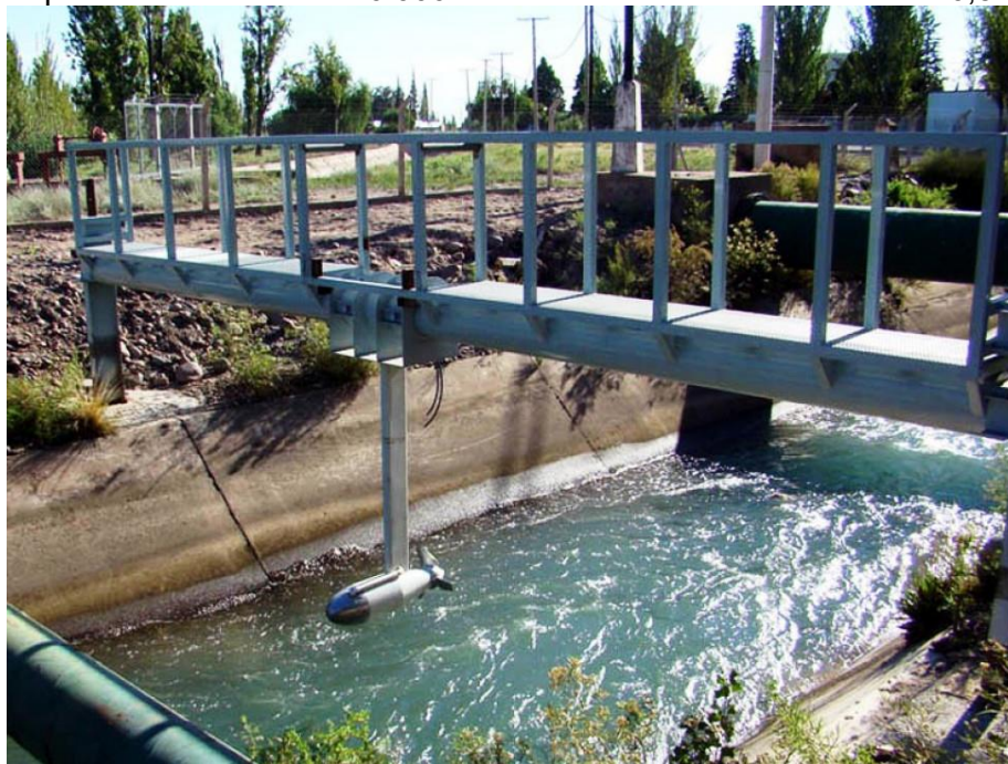
Fig. 1.14 Fotografía de prototipo instalado por INVAP en Canal San Martín - Depto. Luján de Cuyo. [9]
