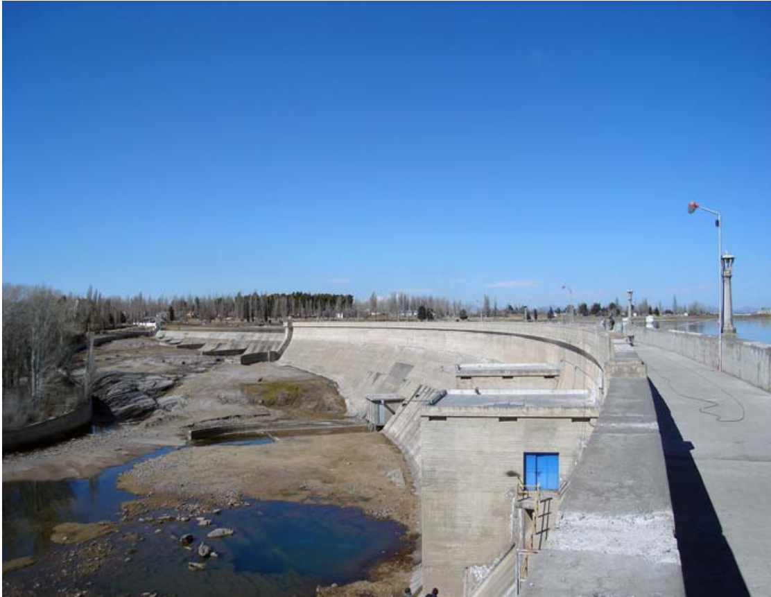
Fot. n° 3.01.- Presa El Nihuil, tipo gravedad planta curva (río Atuel, Mendoza) (de Rodríguez, Fernández y Gutiérrez, 2009)
