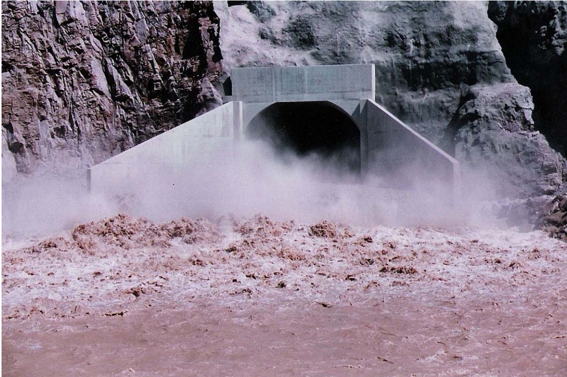
Fot. n° 10.03.- Desagüe de fondo presa Potrerillos. Portal de salida, funcionando como desvío total del río durante la segunda etapa de su desvío.
