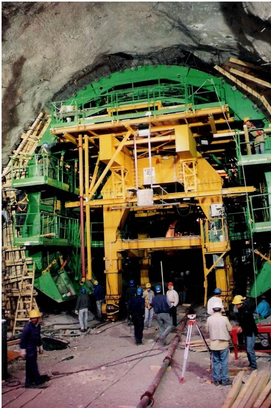
Fig. nº 9.07.- Presa Potrerillos. Túnel para la derivación con el descargador de fondo, en la etapa de hormigonado de la bóveda y hastiales con encofrado metálico CIFA. La conducción fue también utilizada durante la etapa del desvío total del río Mendoza..
