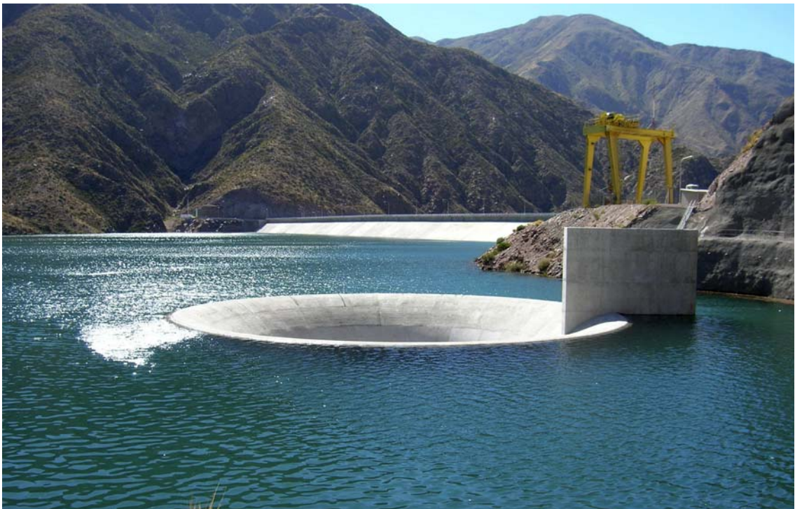
Fot. nº 1.02.- Presa Potrerillos. Aliviadero tipo corola con el nivel de embalse próximo al umbral del vertedero.
