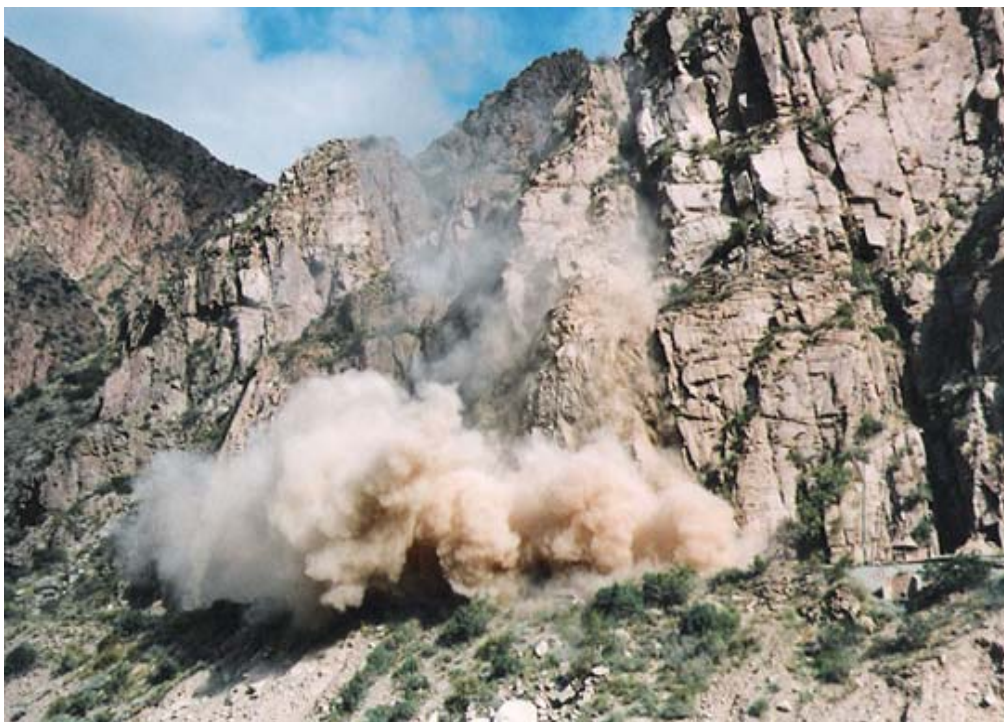
Fot. nº 4.06.- Excavación en roca con explosivos. La realización completa de este tipo de ensayos respalda decisiones de trabajo posteriores.
