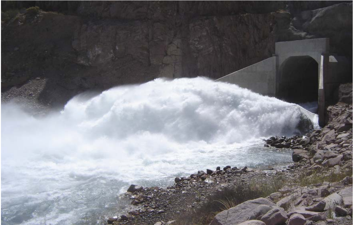
Fot. nº 1.03.- Presa Potrerillos. Desagüe de fondo, derivación de aguas claras
