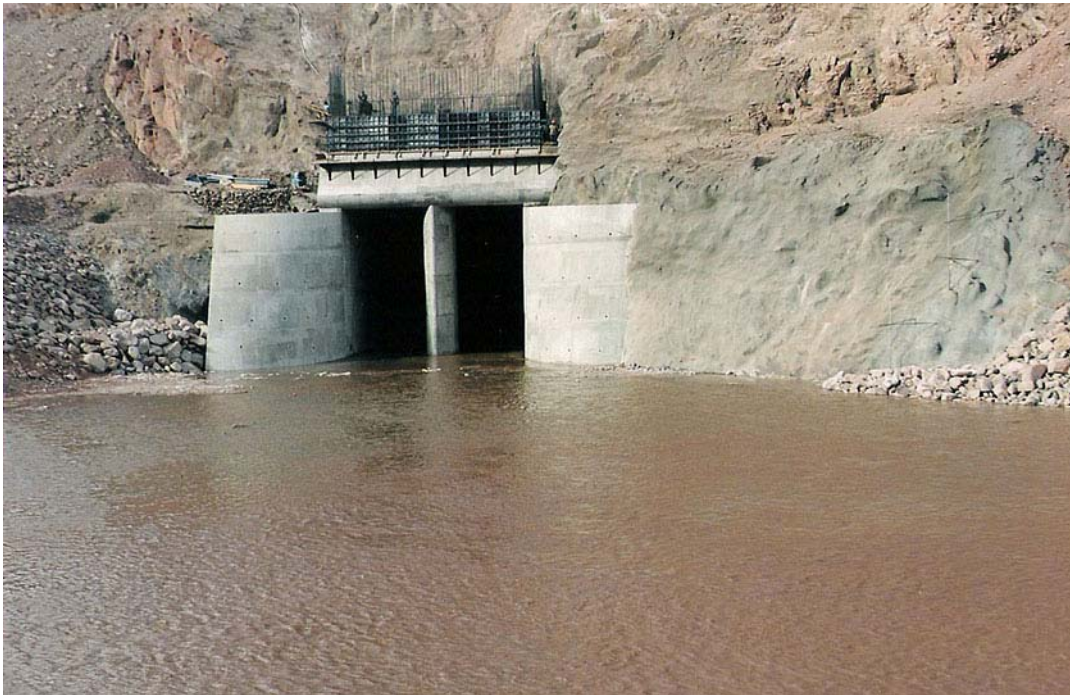
Fot. nº 11.07.- Portal de entrada del túnel de desvío. Etapa del desvío total del río, iniciada en junio /2000. Esto será la toma profunda en el futuro embalse para el descargador de fondo, sin edificio de rejas.
