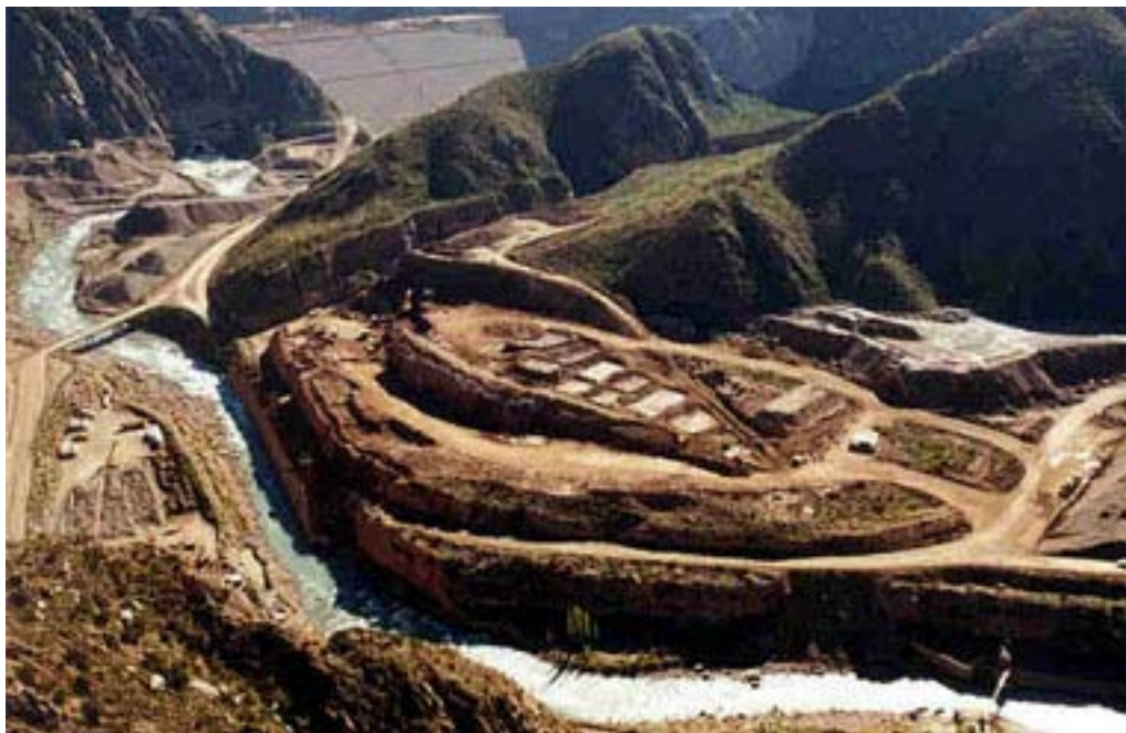
Fot. n° 13.02.- Yacimiento Magali para material 3B. Humedecimiento in-situ por sectores.
