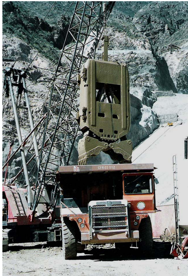
Fot. nº 8.06.- Pala almeja para excavación del muro colado. (Camión fuera de ruta de 50 t)
