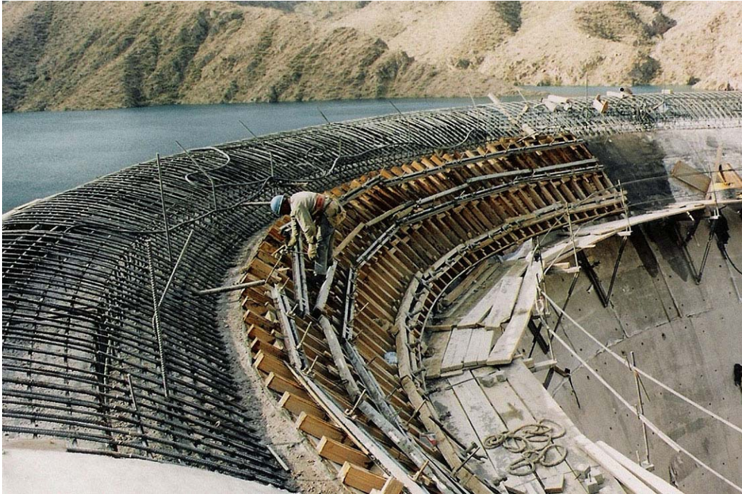
Fot. nº 9.03.- Aliviadero Potrerillos. Armaduras para el umbral del vertedero.
