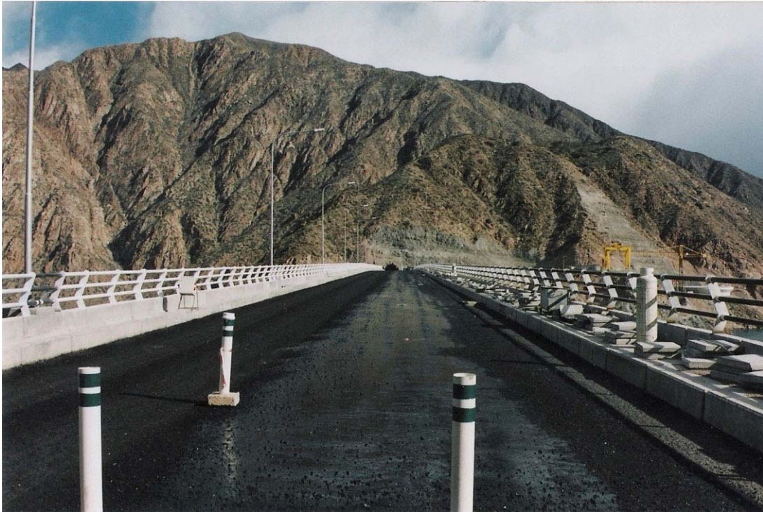
Fot. N° 14.3.- Presa Potrerillos. Vista del coronamiento terminado.
