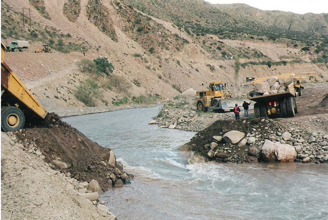
Fot. n° 11.03.- Desvío del río, etapa 1. Acumulación de material para cerrar el espigón.
