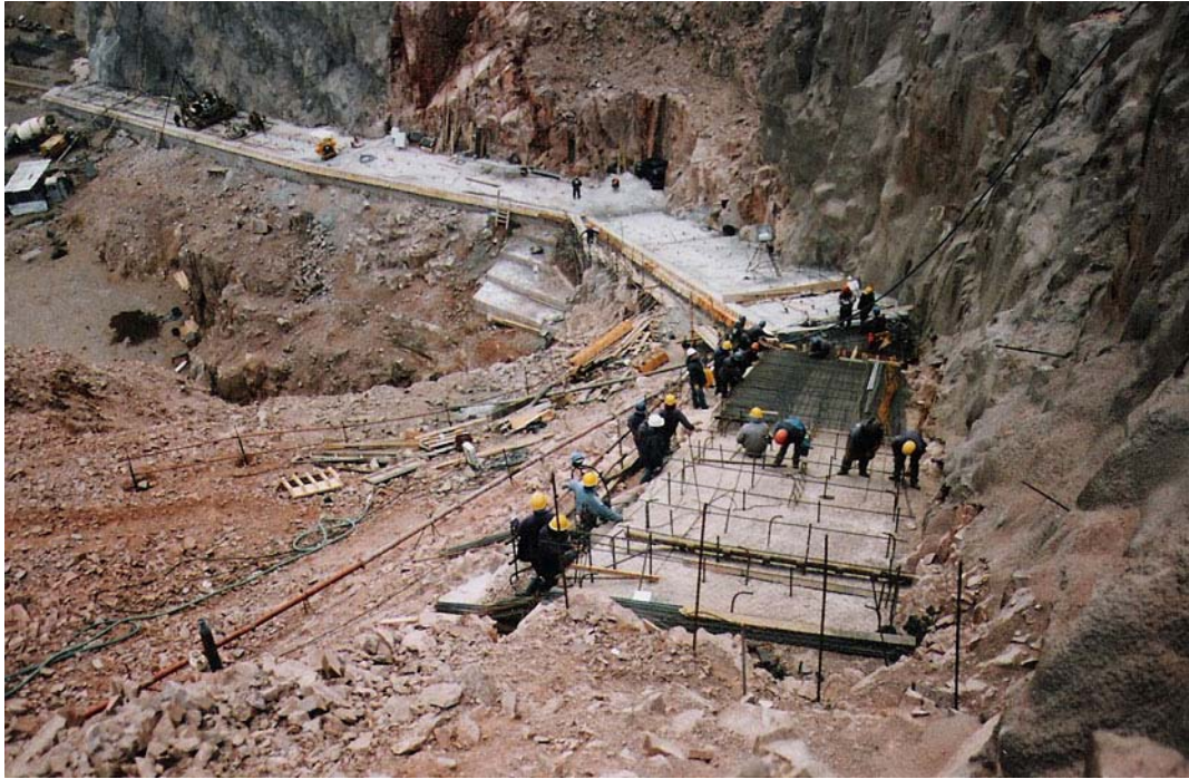
Fot. nº 8.01.- Presa Potrerillos. Construcción de plinto, sector inferior de margen derecha
