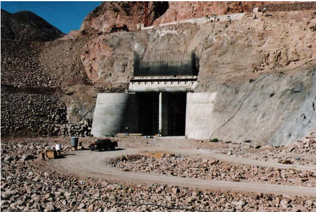
Foto. Nº 10.02.- Desagüe de fondo presa Potrerillos. Portal de entrada en la embocadura, en vías de su terminación.
