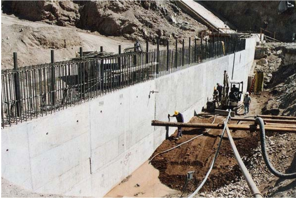
Fot. n° 03.- Presa Potrerillos. Plinto articulado a extremo derecho del muro colado
