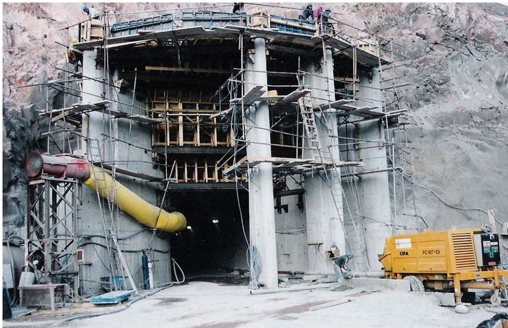
Fot. nº 10.06.- Toma Central H. Cacheuta. Portal de entrada al túnel de aducción en el embalse Potrerillo. Edificio de rejas en construcción.
