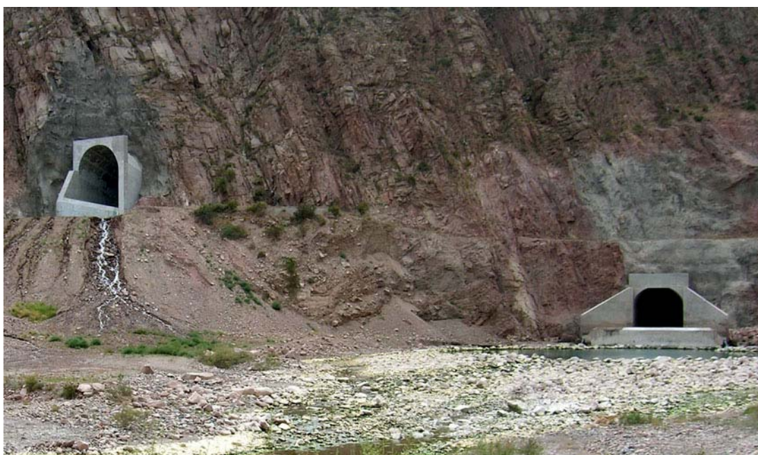
Fot. nº 9.06.- Aliviadero Potrerillos. Portal de salida en trampolín del túnel de descarga (arriba izquierda). Abajo, portal de salida del descargador de fondo.
