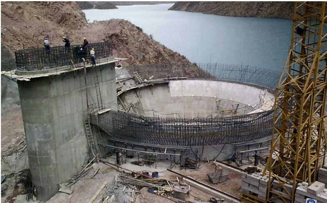
Fot. nº 9.02.- Aliviadero Potrerillos. Etapa parcial de hormigonado de la corola
