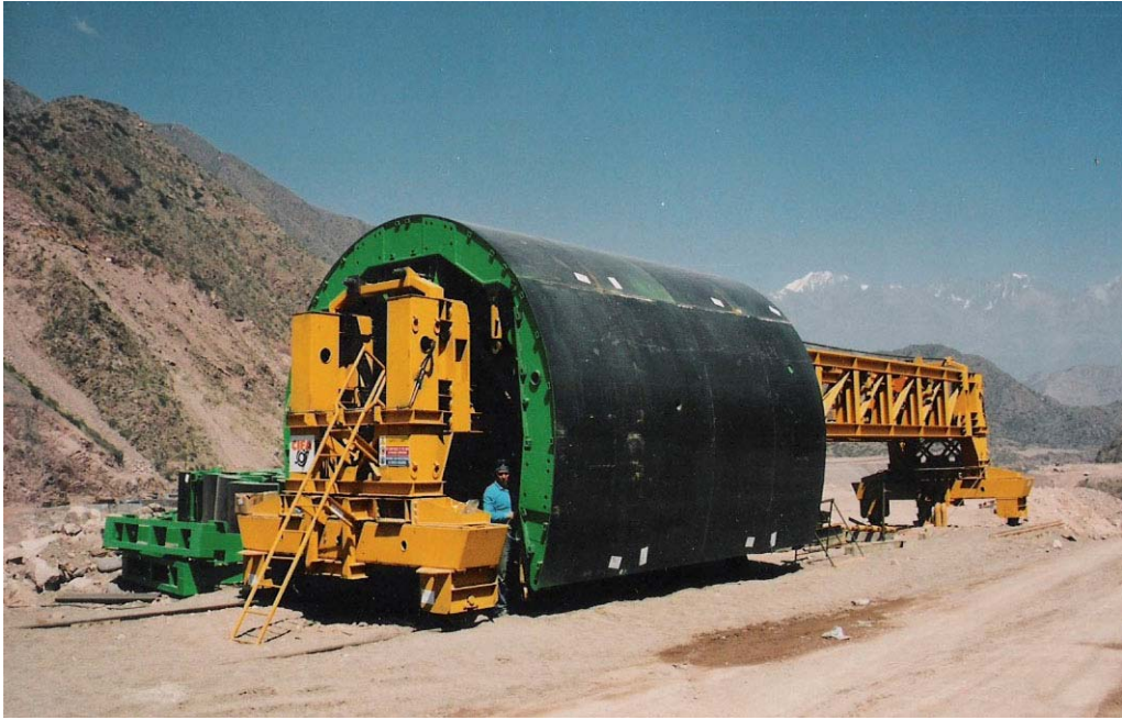
Fot. nº 13.03.- Encofrado metálico retractil CIFA, para bóveda de túneles
