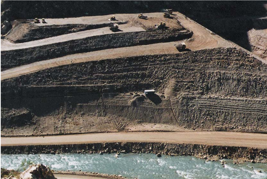
Fot. nº 11.11.- Desvío parcial del río durante la primer etapa. Se construye la fundación y parte del cuerpo del estribo de margen izquierda de la presa. (Mayo/2000)
