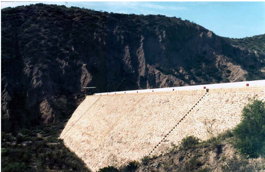
Fot. n° 5.02.- Presa Maure, tipo CFRD (río seco Maure, Mendoza) (gentileza de la Dirección de Hidráulica de Mendoza)
