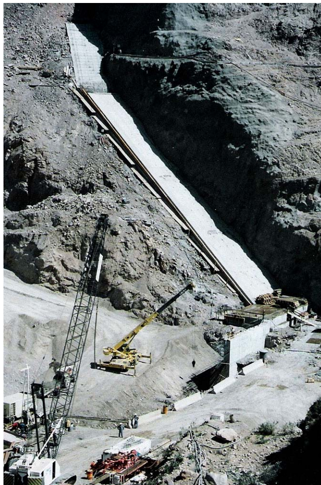
Fot. n° 8.04.- Vista general del punto triple derecho, donde confluyen plinto margen derecha, plinto articulado de pie de presa y muro colado.
