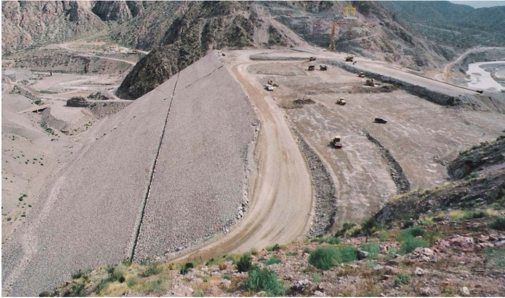
Fot. n° 11.15.- La protección del talud de aguas abajo se construye a medida que el relleno progresa en altura. Situación del estribo de margen izquierda en febrero/2000.
