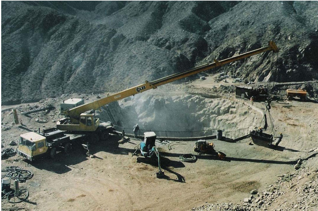
Fot. nº 9.01 Aliviadero Potrerillos. Excavación en pozo para el tramo vertical de la conducción
