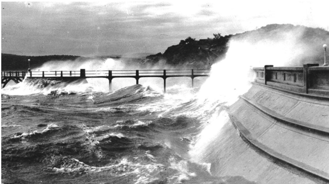
Fot. nº 6.01.- Presa Río III (Córdoba)) Rociones durante una tormenta de verano, alcanzan a mojar el coronamiento. ( Gentileza Orsep, Ing. G. Gutierrez )
