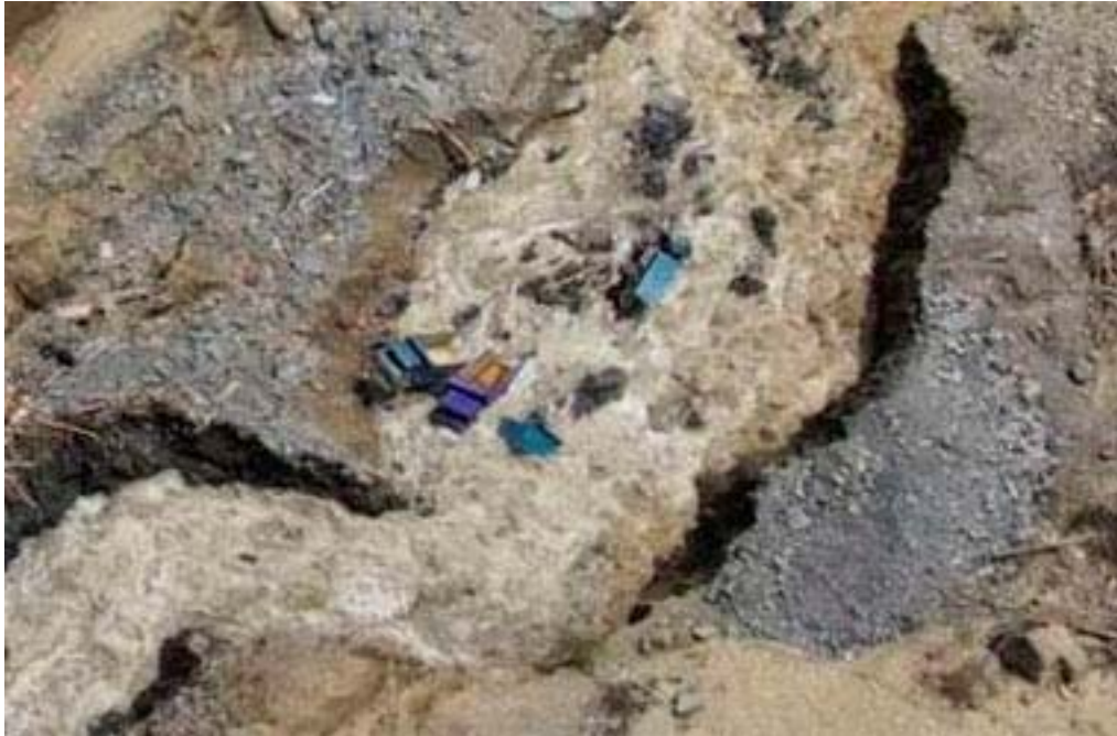
Fot. n ° 12.07.- El progreso de la erosión no dio tiempo para retirar todo el equipo de construcción empleado.
