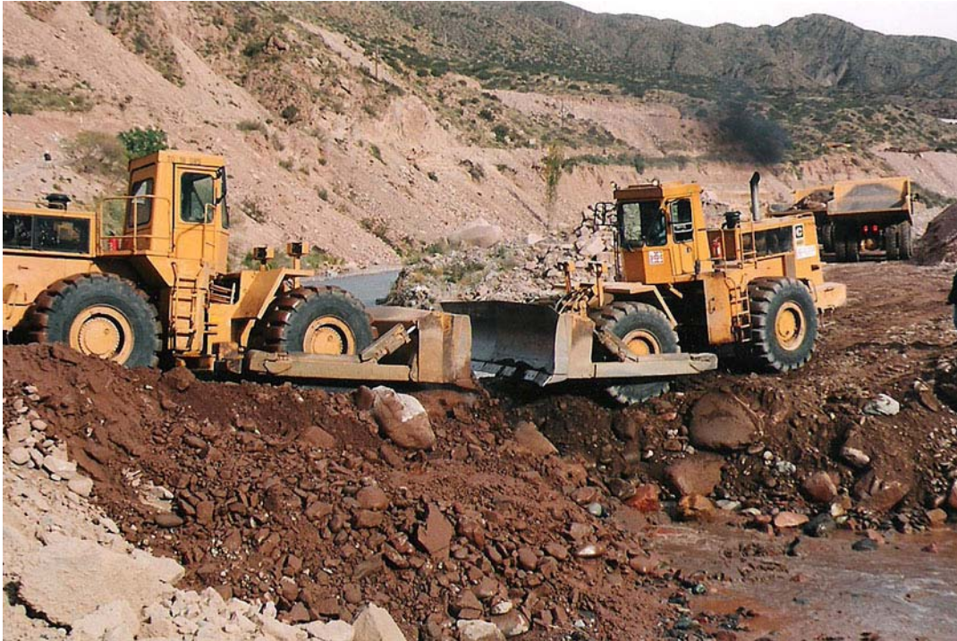
Fot. nº 11.05.- Desvío del río. Última fase de construcción del cierre del espigón. Fin de la etapa 1.(Junio/2000)
