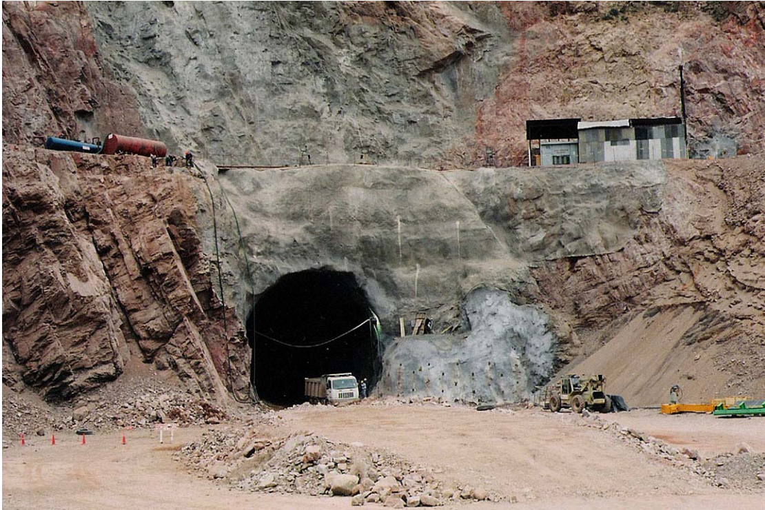
Fot. nº 10.01.- Desagüe de fondo presa Potrerillos. Excavación de túnel, primer etapa para implementación de suembocadura.
