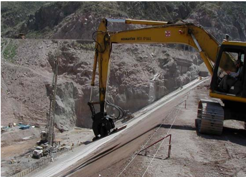
Fot. 7.04.- Compactación final en el talud de la base con plancha vibradora
