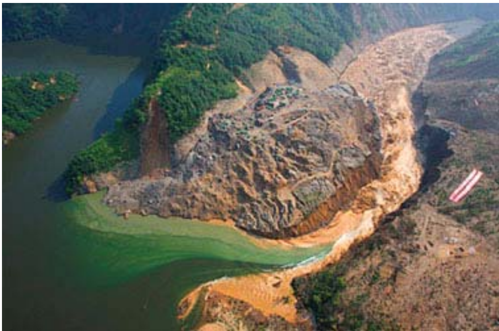
Fot. 12.06.- Brecha abierta por la erosión a partir del canal excavado. El caudal así erogado llegó a 1.800 m 3 /s. Se puede apreciar la magnitud del deslizamiento de tierra que creó un embalse en el cauce del río.
