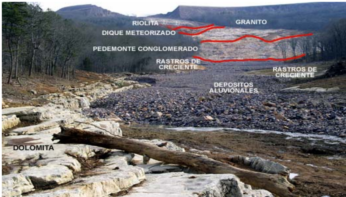
Fot.nº 2.05.- Represa Taum Sauk (Missouri, EEUU). Rotura por sobrepaso el día 15 /12/2005. Erosión de ladera por el derrame del agua, que descubre la litología superficial del terreno rocoso ( bajada de Internet ).
