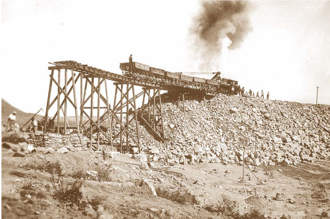
Fot. n° 2,01.- Presa Río III (Córdoba, Argentina), construcción de tipo CFRD con escollera vertida. Se nota la segregación del material más grueso. ( Gentileza Orsep, Ing. G. Gutierrez )
