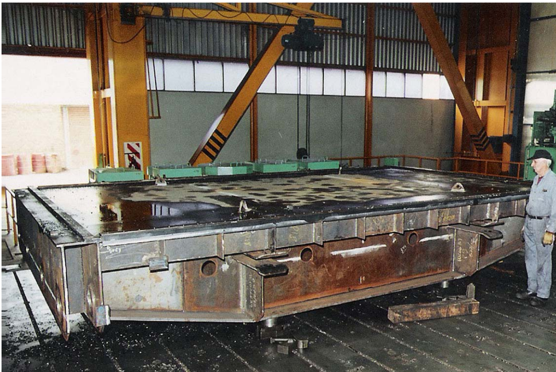
Fot. n° 10.04.- Desagüe de fondo presa Potrerillos.- Ataguía para mantener en seco el recinto de trabajo para montar el equipo hidromecánico del desagüe de fondo.
