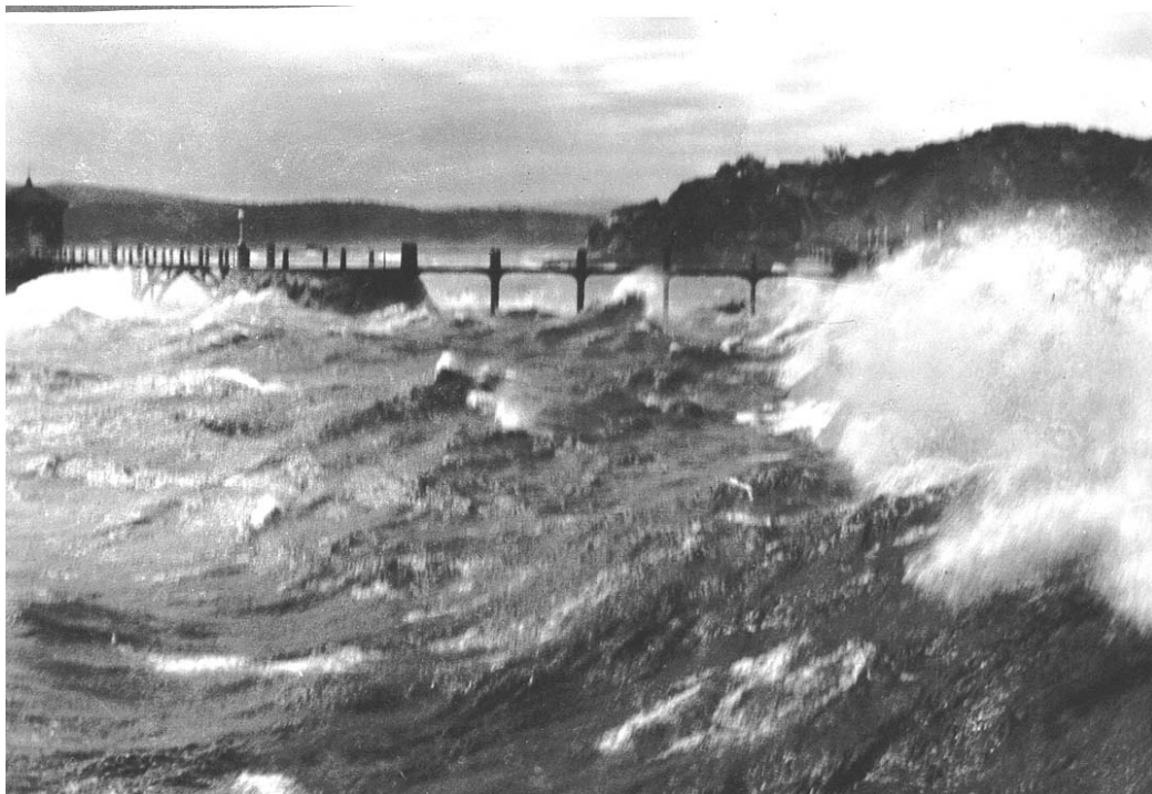
Foto nº 6.02.- Presa Río III. Rociones aún más violentos, alcanzan a sobrepasar el coronamiento. ( Gentileza Orsep, Ing. G. Gutierrez )
