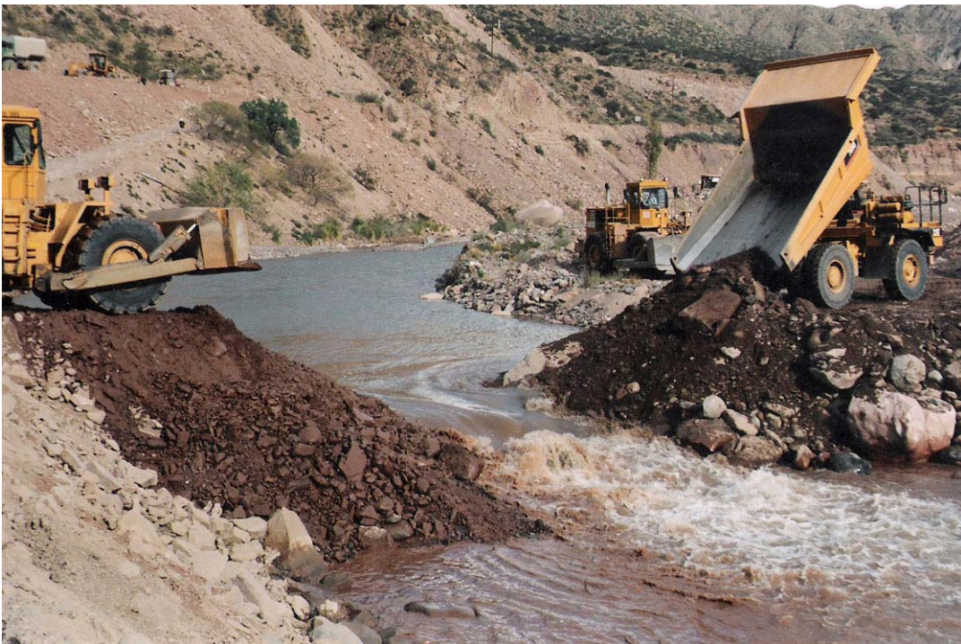
Fot. n° 11.04.-La acumulación paulatina de materiales y su empuje hacia el vano con topadoras permitió ir cerrando el vano por el cual circulaba el río durante el estiaje del año 2000.
