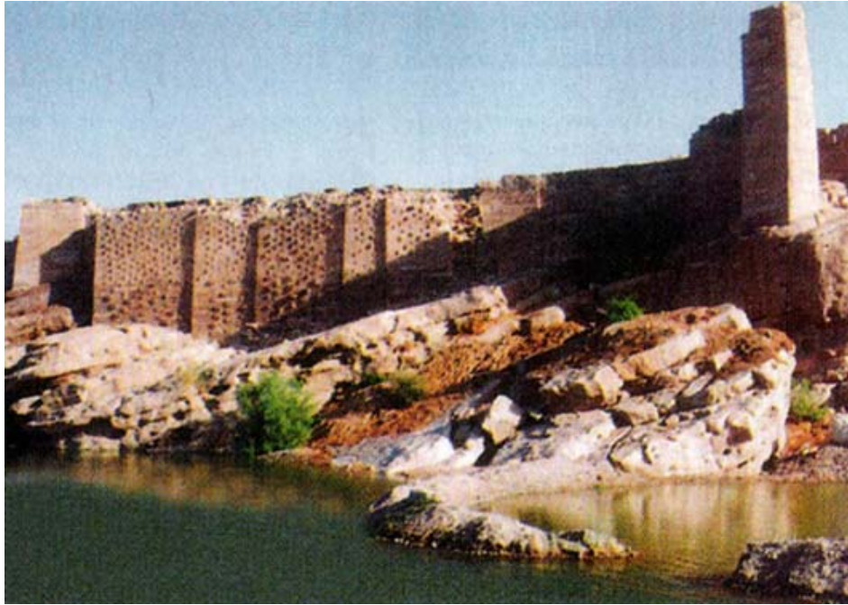
Fot. nº 2.07.- Presa Marib (Yemen, destruida en el siglo VII de la era actual, después de más de mil años de prestación de servicios). Hoy, lugar de turismo ( bajada de Internet )
