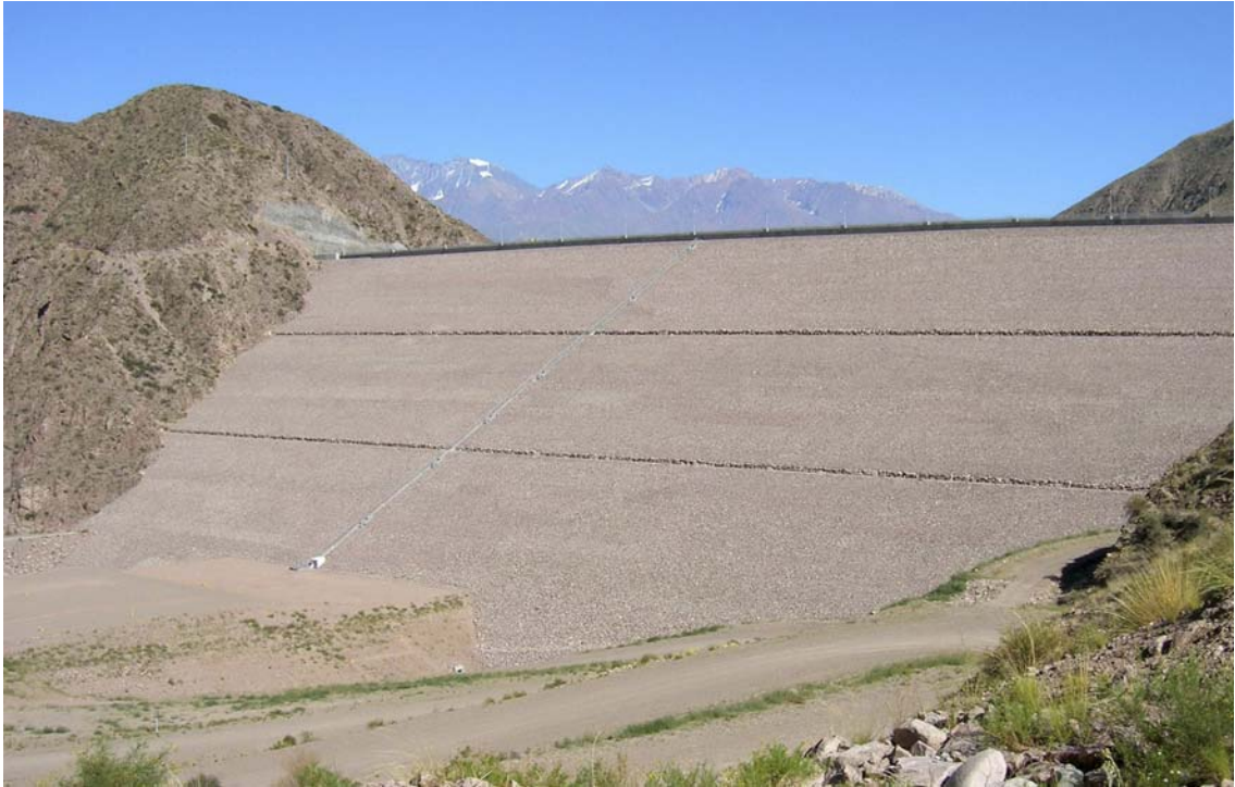
Fot. nº 1.01.- Presa Potrerillos. Paramento de aguas abajo
