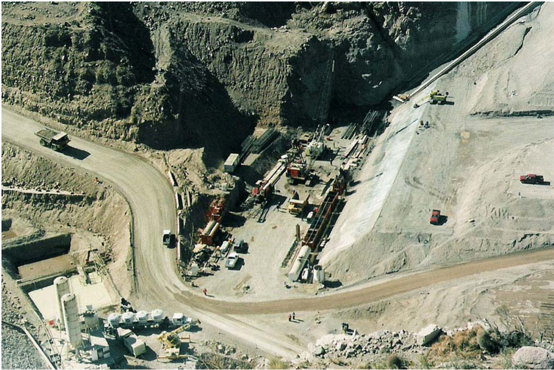
Fot. n° 11.17.- Presa Potrerillos. Vista general del obrador para la construcción del muro colado y del camino de acceso para el transporte de materiales, tanto para la presa como para el muro.. Se está en la fase 2 del desvío del río en forma total, para que estos trabajos se realicen totalmente en seco.
