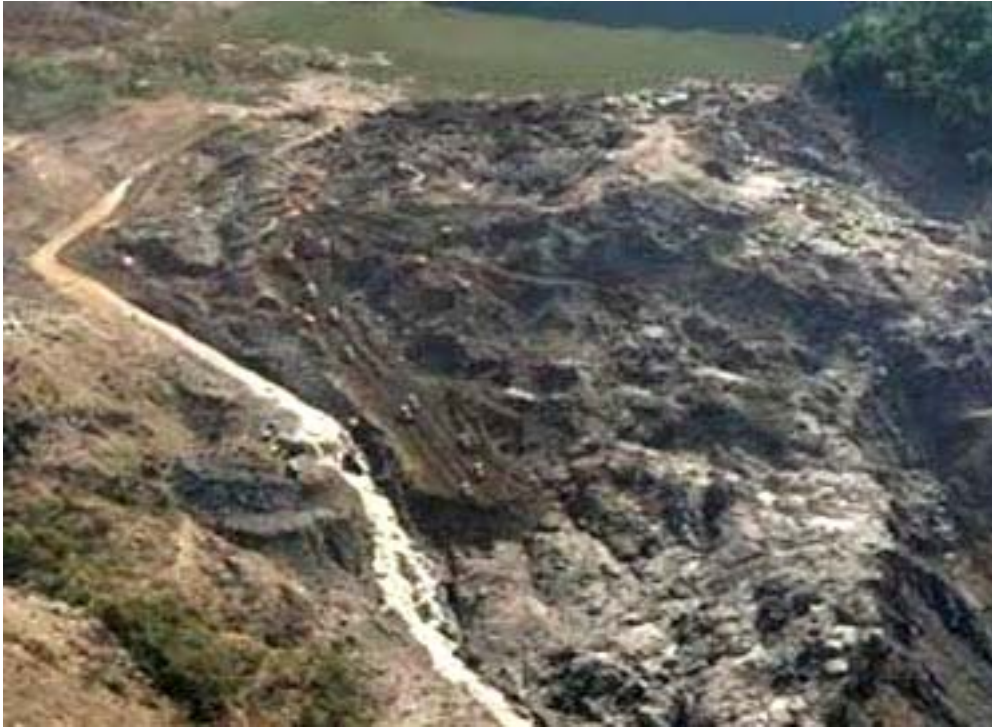
Fot. 12.05.- Deslizamiento de talud lago Tangjiashan( China, terremoto del 12/05/08). Canal excavado sobre margen derecha de la presa formada por el deslizamiento para vaciar el embalse.
