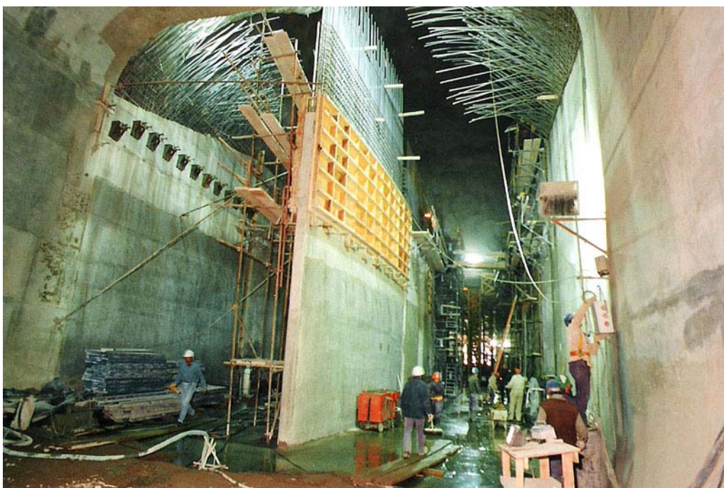
Fot. nº 12.01.- Presa Potrerillos. Pila central en el túnel de desvío en cuyos vanos se instalarán los dispositivos de control del desagüe de fondo-
