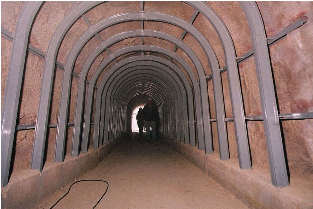
Fot. nº 13.04.- Entibamiento metálico permanente en galería de ventilación de la chimenea de equilibrio de la Central H. Cacheuta. Paredes gunitadas.
