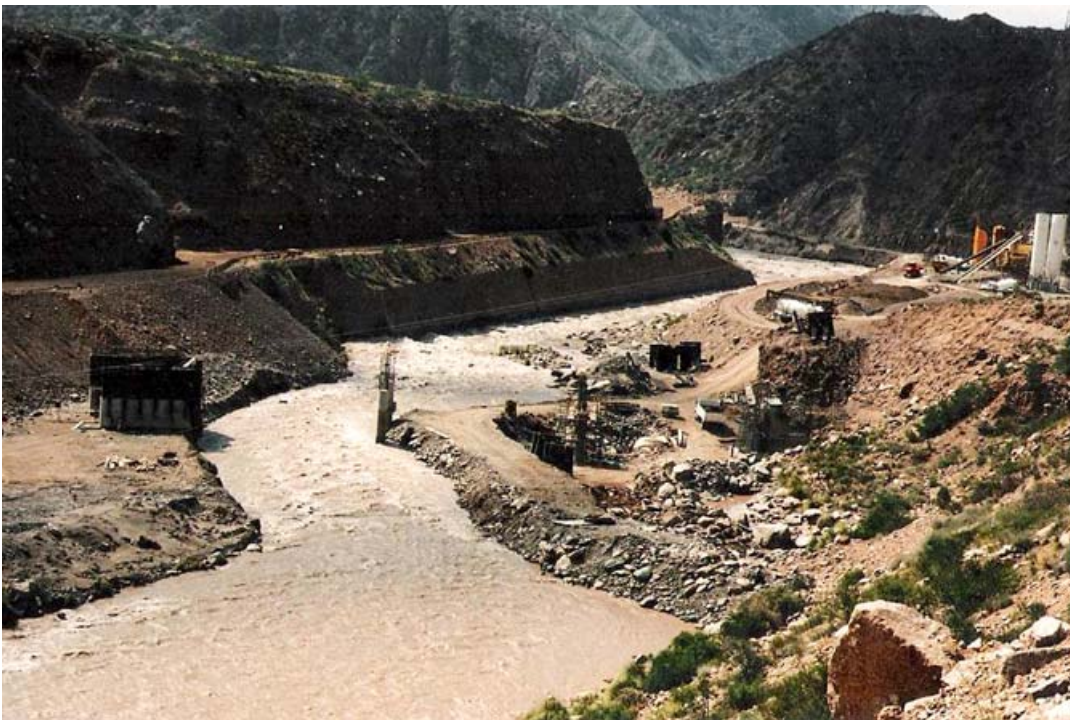
Fot, nº 11.02.- Desvío del río, etapa 1. Inicio de la fundación del estribo izquierdo para el puente de servicio entre las dos márgenes. Este puente permanece todavía en funciones, bajo el mismo circula agua que viene del embalse a través de la roca de fundación y del sistema de estanqueidad de la presa. (Diciembre 2000).
