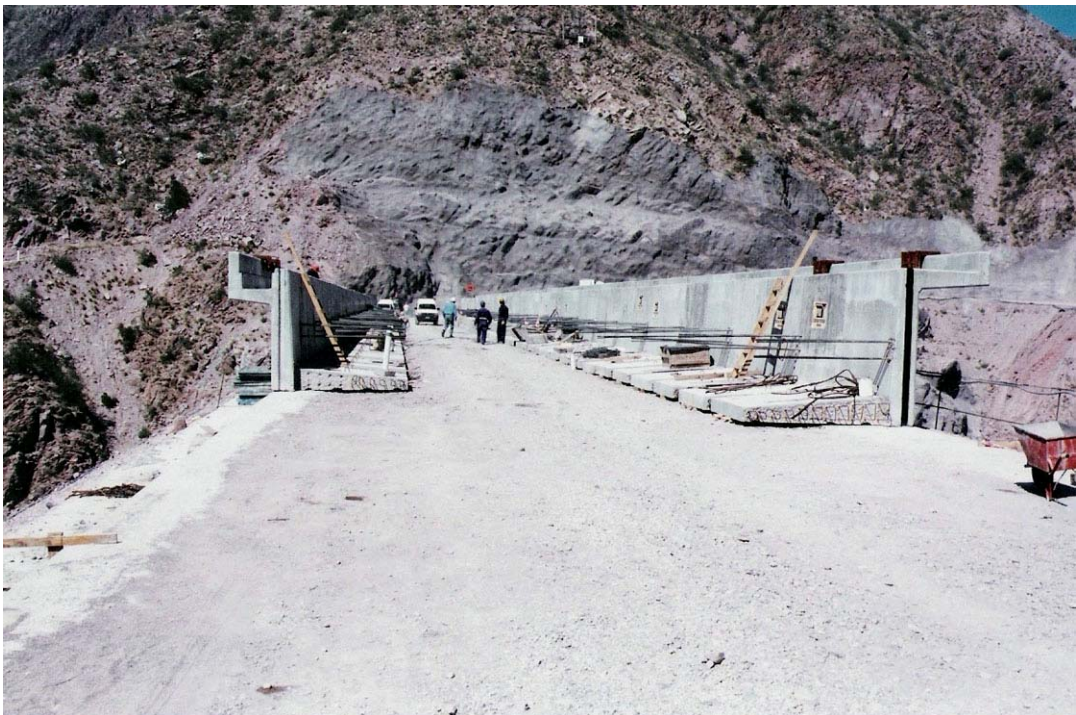
Fot. Nº 14.1.- Coronamiento con elementos prefabricados de hormigón
