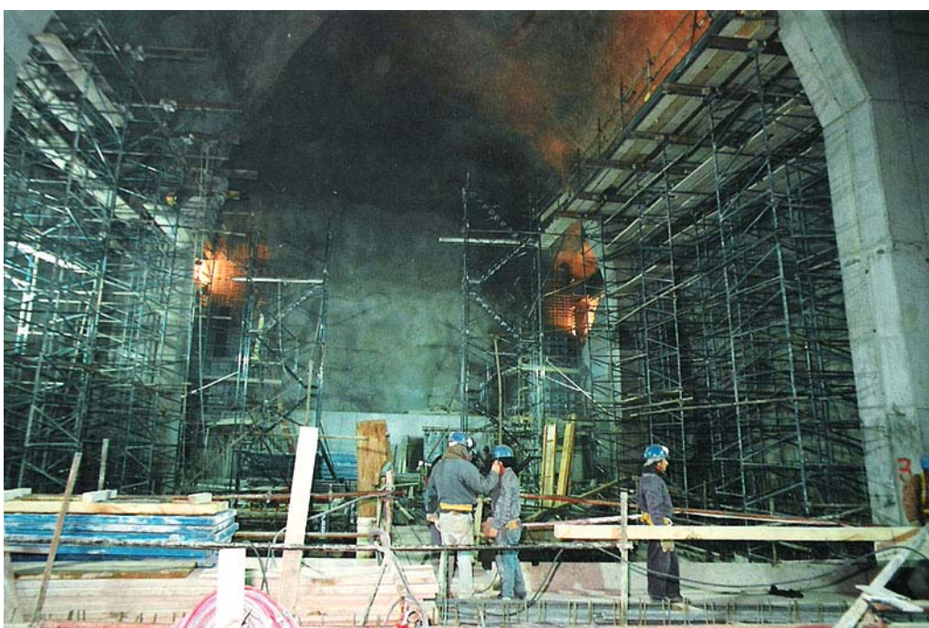
Fot. nº 12.02.-Presa Potrerillos. Caverna para el montaje de los órganos de control del desagüe de fondo.
