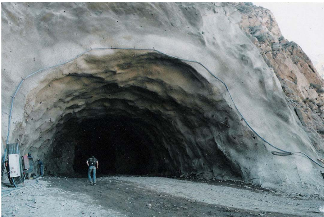
Fot. nº 9.04.- Aliviadero Potrerillos.-Excavación para la bóveda del túnel de descarga
