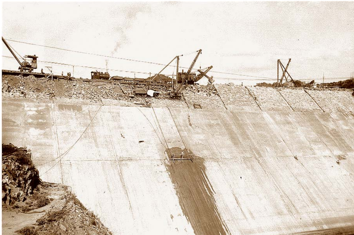
Fot. n° 2.02.- Presa Río III, construcción de la pantalla de hormigón, con la configuración antigua de juntas horizontales (Córdoba, 1936). ( Gentileza Orsep, Ing. G. Gutierrez )
