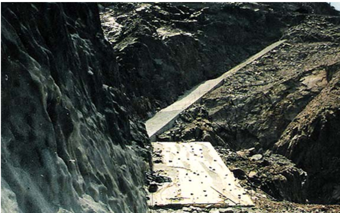
Fot. nº 8.02.- Presa Potrerillos. Plinto. Sector superior de margen izquierda
