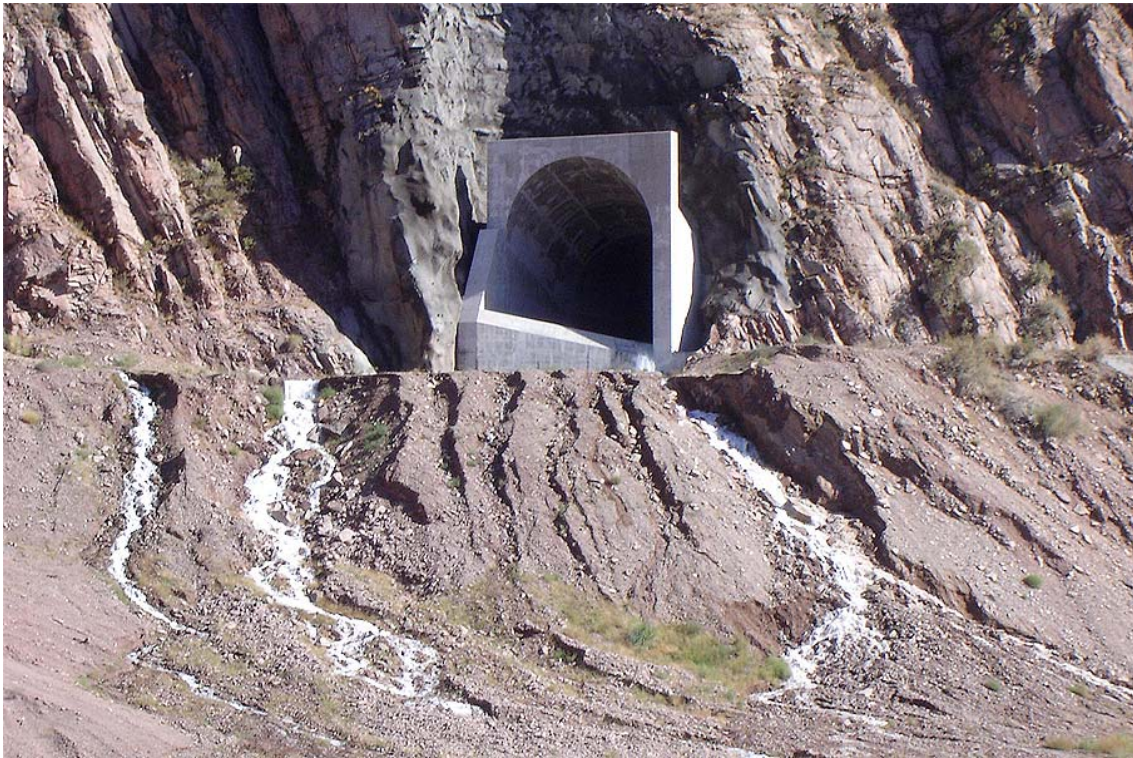
Fig. nº 1.05.- Presa Potrerillos. En el aliviadero la conducción termina con la restitución al río por medio de una trampolín cuya parte final se ve en esta imagen. El agua que se infiltra en el macizo rocoso tiene salida al exterior, donde su caudal se afora regularmente, a fin de apreciar el comportamiento de la obra, incluido lo que el hombre hizo y lo que ofreció la naturaleza, objeto fundamental de las actividades de mantenimiento y conservación.
