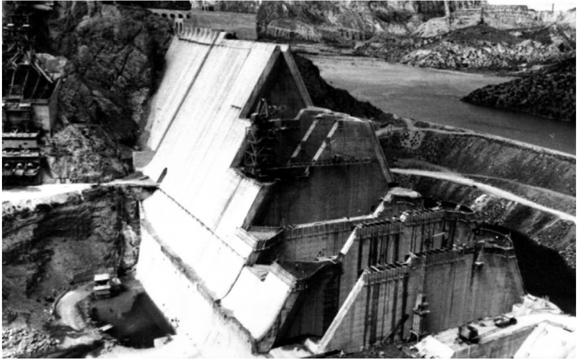
Fot. nº 5.05.- Presa Valle Grande, tipo gravedad de contrafuertes. Estado intermedio de su construcción. (Gentileza Ing. J. Vairani)
