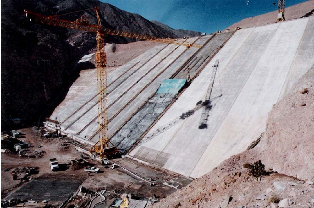
Fot. nº 7.01.-Presa Potrerillos. Construcción de la pantalla de hormigón, sector central.
