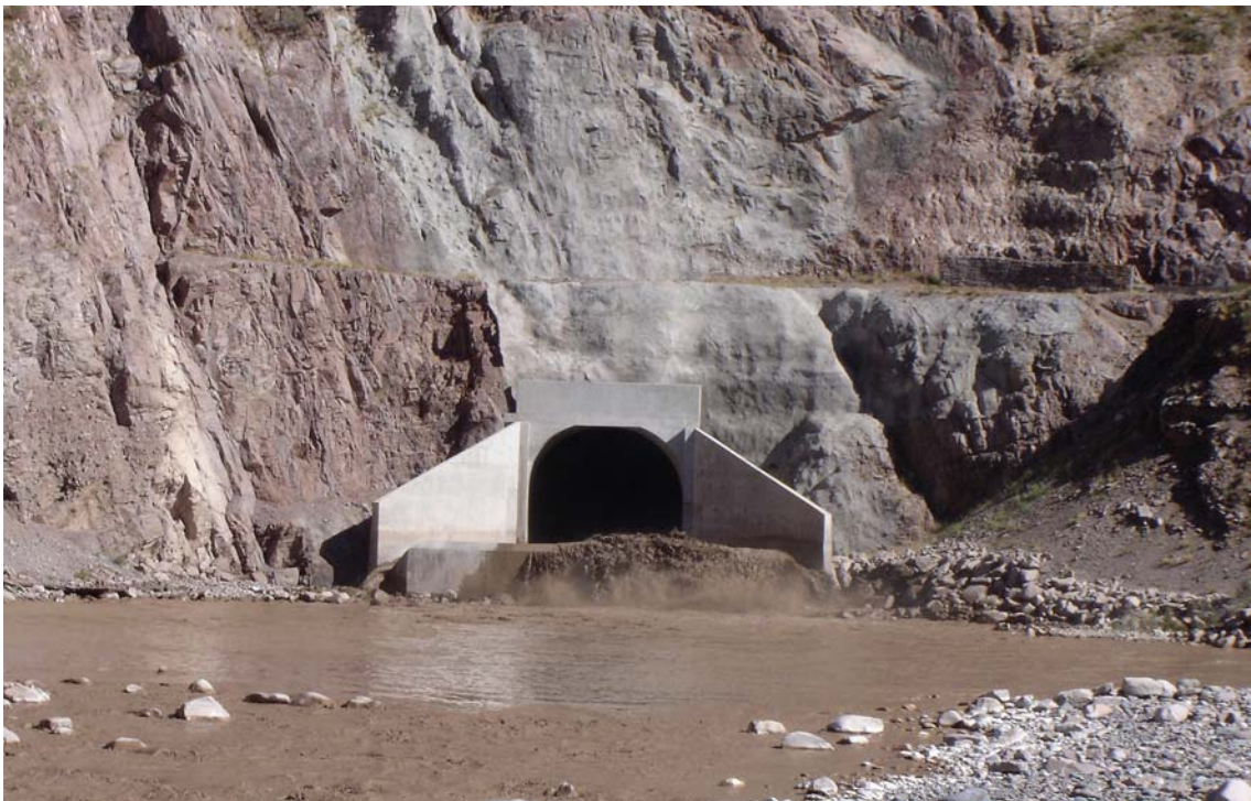
Fot. nº 1.04.- Presa Potrerillos. Desvío del río. Funcionamiento durante la construcción con aguas turbias.
