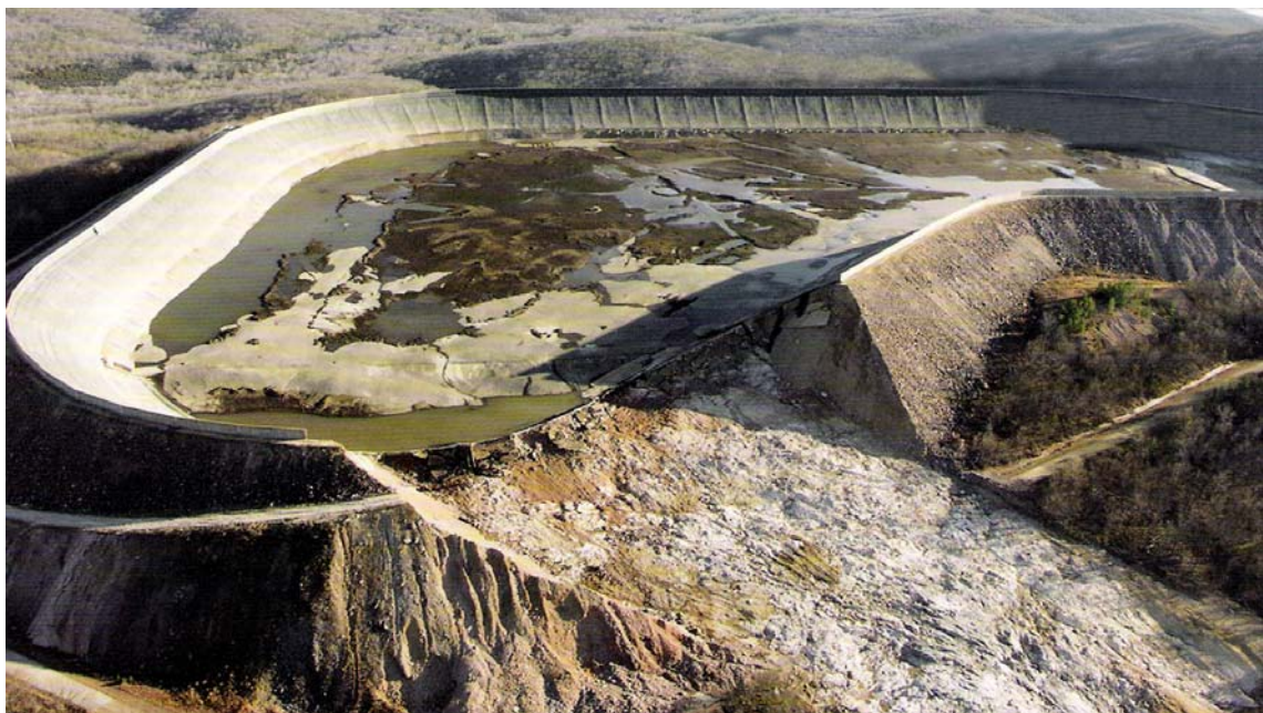
Fot. nº 2.06.- Represa Taum Sauk. Colapso por sobrepaso. Se ve el tipo de obra del cierre (CFRD) en la pared derecha de la brecha, la retroerosión ha interesado parte de la solera del vaso. ( adaptada de Internet )
