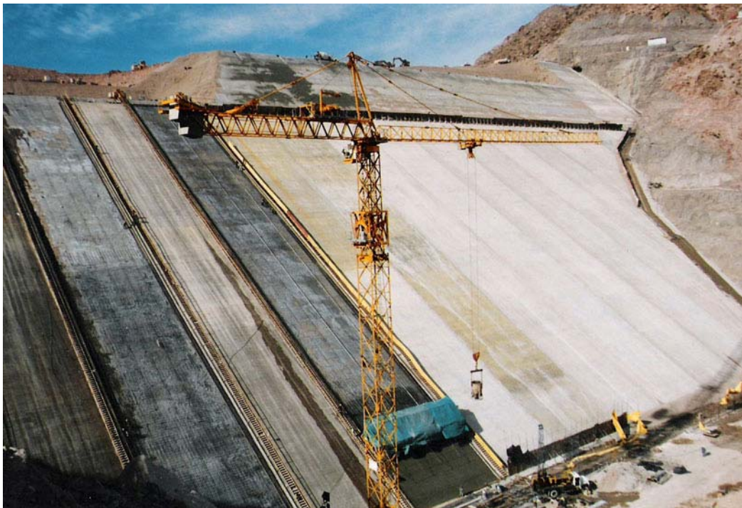
Foto nº, 7.02.-Presa Potrerillos. Construcción de la pantalla de hormigón por fajas alternadas (ancho 16 m) con encofrado deslizante
